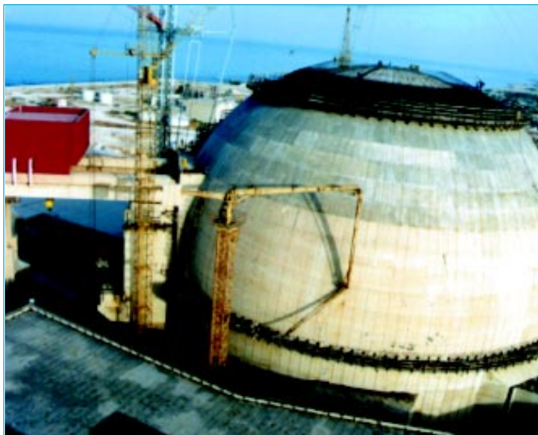
Достройка блока 1 (ВВЭР-1000) АЭС «Бушер», Иран, 2000 г.
