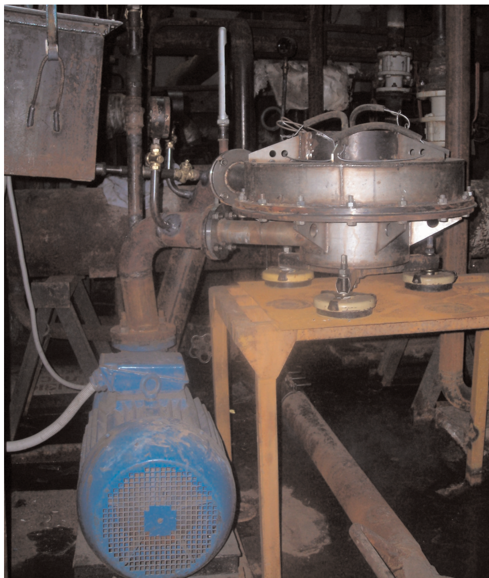
Рис. 1. Тепловой пункт на базе БРАВО
