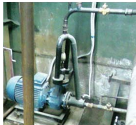
Рис. 4. "Вихревой" теплогенератор ВТУ-22 на электронасосном агрегате
